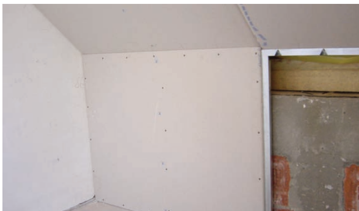
Montaż poszycia z płyt gipsowo-kartonowych do profili V i CD 60 stanowiących konstrukcję zabudowy ścianki kolankowej.
