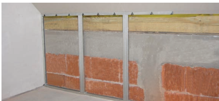
Konstrukcja z profili V i Profili CD 60 stanowiąca zabudowę ścianki kolankowej.
