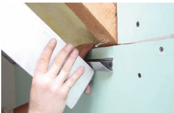
Dogięcie dłuższego ramienia profilu V w celu uzyskania jego odpowiedniego kąta nachylenia.
