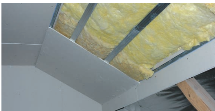
Montaż poszycia z płyt gipsowo-kartonowych do profili V i CD 60 stanowiących konstrukcję zabudowy skosu poddasza.
